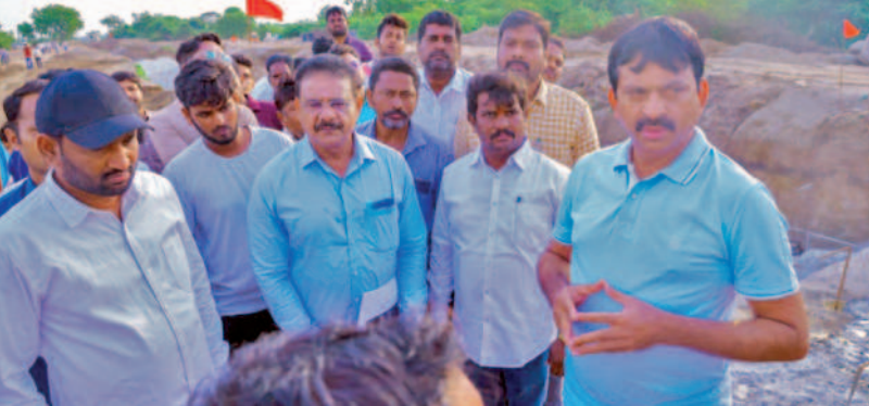
బుధవారం మునీరువాగు రిటైనింగ్ వాల్ నిర్మాణ పనులను పరిశీలిస్తున్న మంత్రి పొంగులేటి
